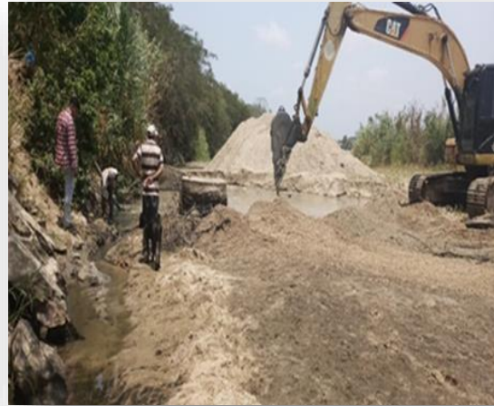
CONSTRUCCION DE ALBARRADAS EN LOS SECTORES LA ISLA, CHACRAS, BALSALITO
